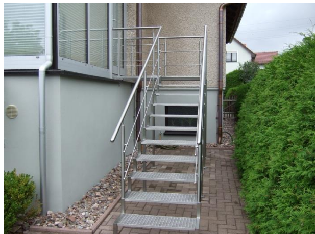
Edelstahl-Treppe mit Geländer im Außenbereich
